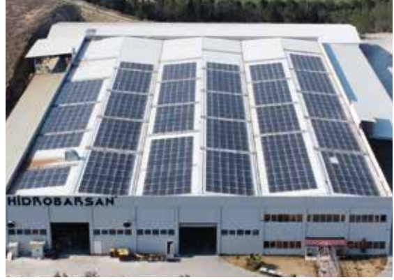
HİDROBARSAN 500KWp ÇATI - DENİZLİ
