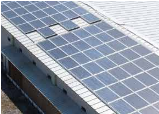
BİLGİN BESİCİLİK 130KWp ÇATI - DENİZLİ
